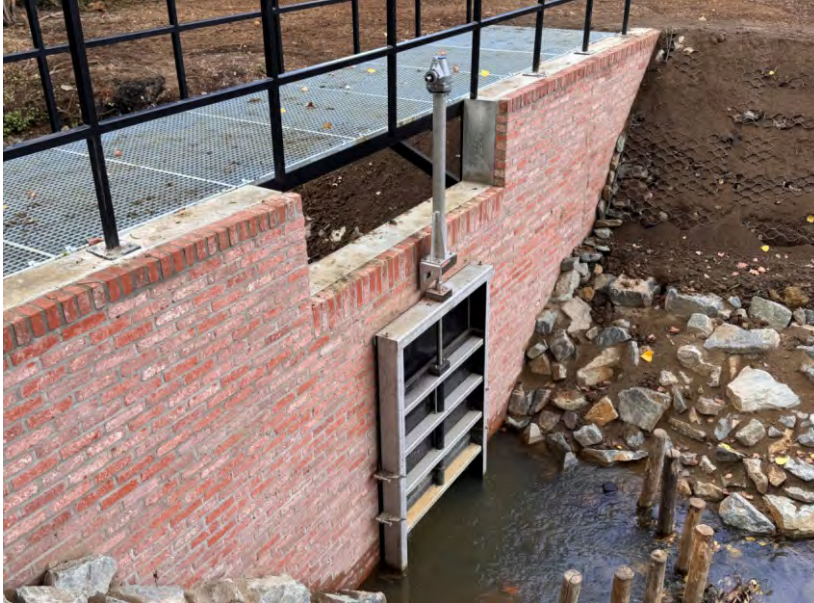
Schuif op duiker die werkt als afknijpingsmechanisme
