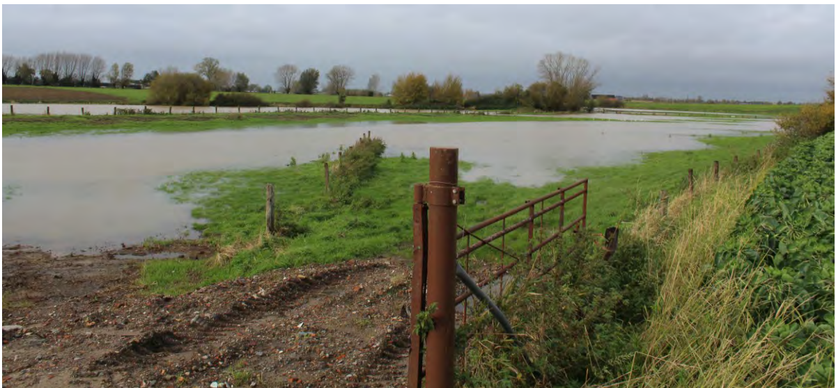
Zicht op de percelen ter hoogte van de Lindesteenweg (bij waterpeil 3mTAW)(2023)
