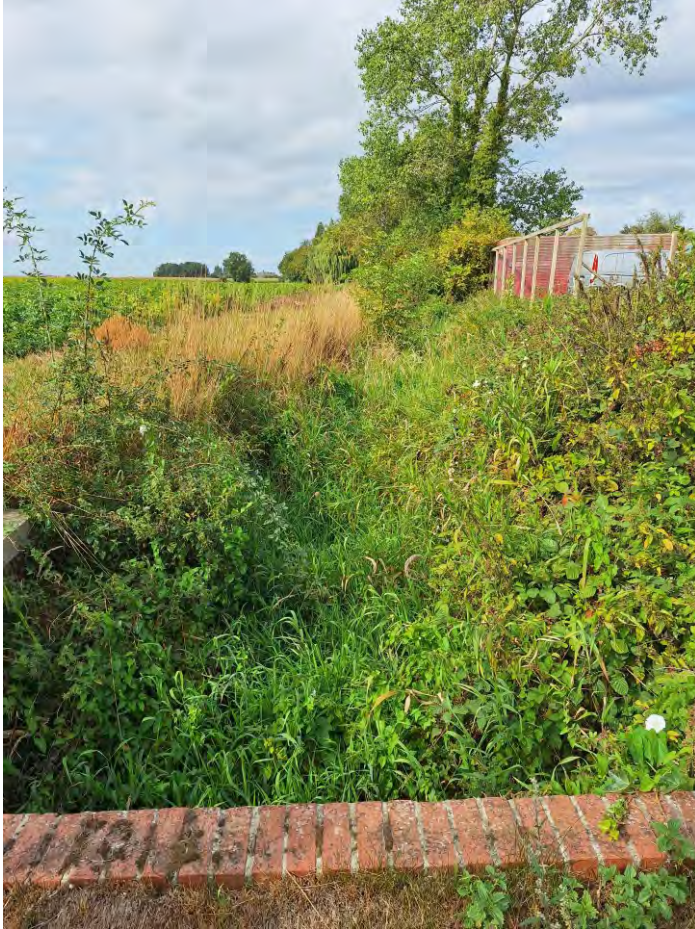
Bestaande situatie ter hoogte van maatregel 5 en 6 (2024-2025)
