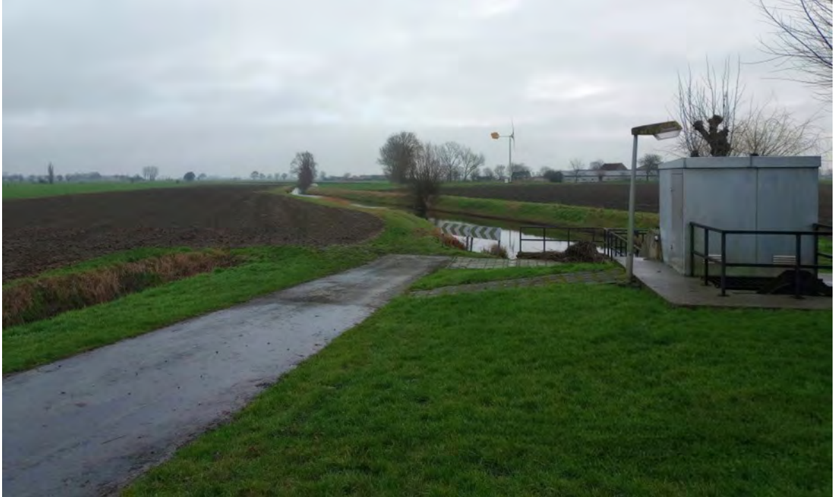
Zicht op het bestaand pompemaal Lolege dat geoptimaliseerd wordt ©Sam Coulier, Westkustpolder
