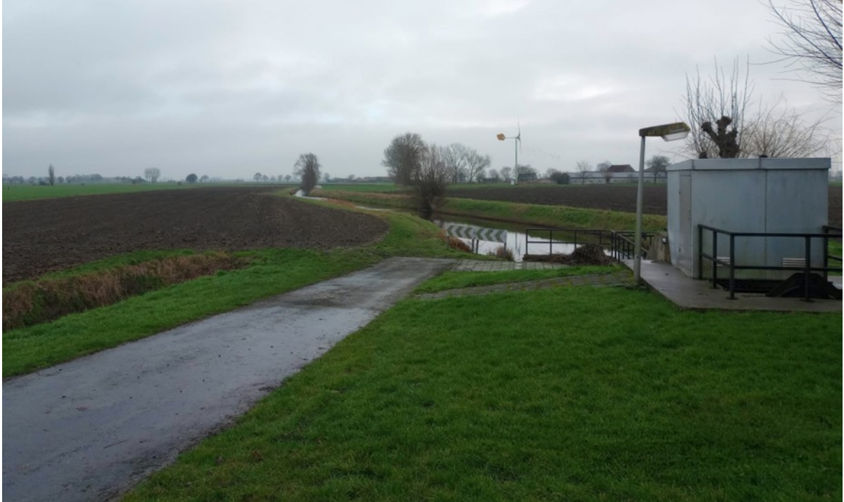
Zicht op het bestaand pompgebouw Lolege dat geoptimaliseerd wordt ©Sam Coulier, Westkustpolder
