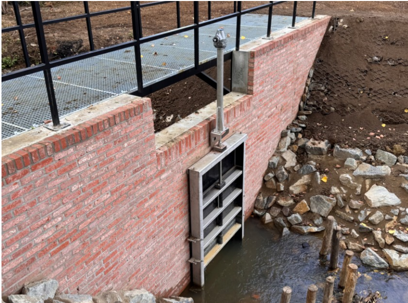
Schuif op duiker die werkt als afknijpingsmechanisme
