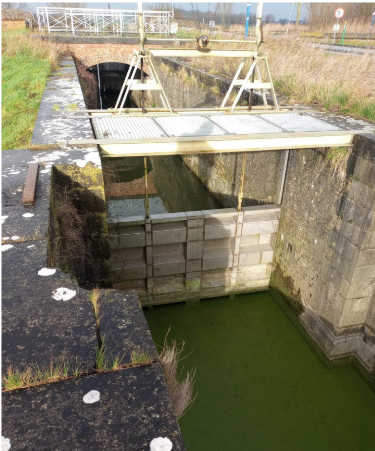
Sloggat sluis, ©Sam Coulier, Westkustpolder
