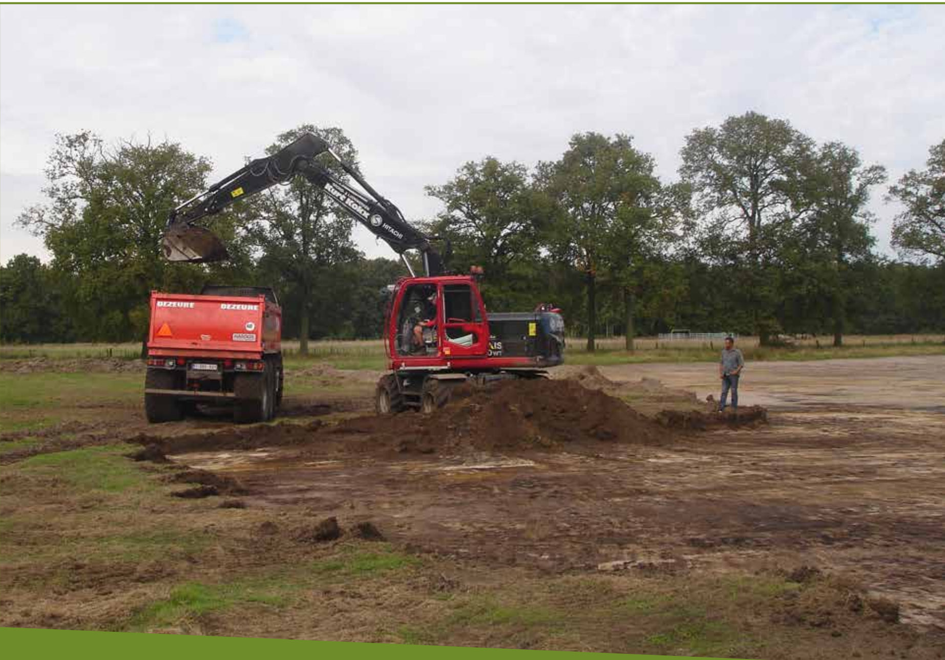
afgraven voedselrijke bouwvoor en herstel oorspronkelijk microreliëf
