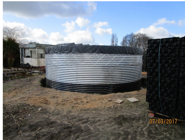
Opslag spuistroom 60 m 3 geplaatst
