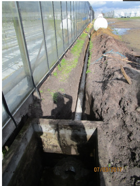
Bijkomende afvoerbuys drainwater
