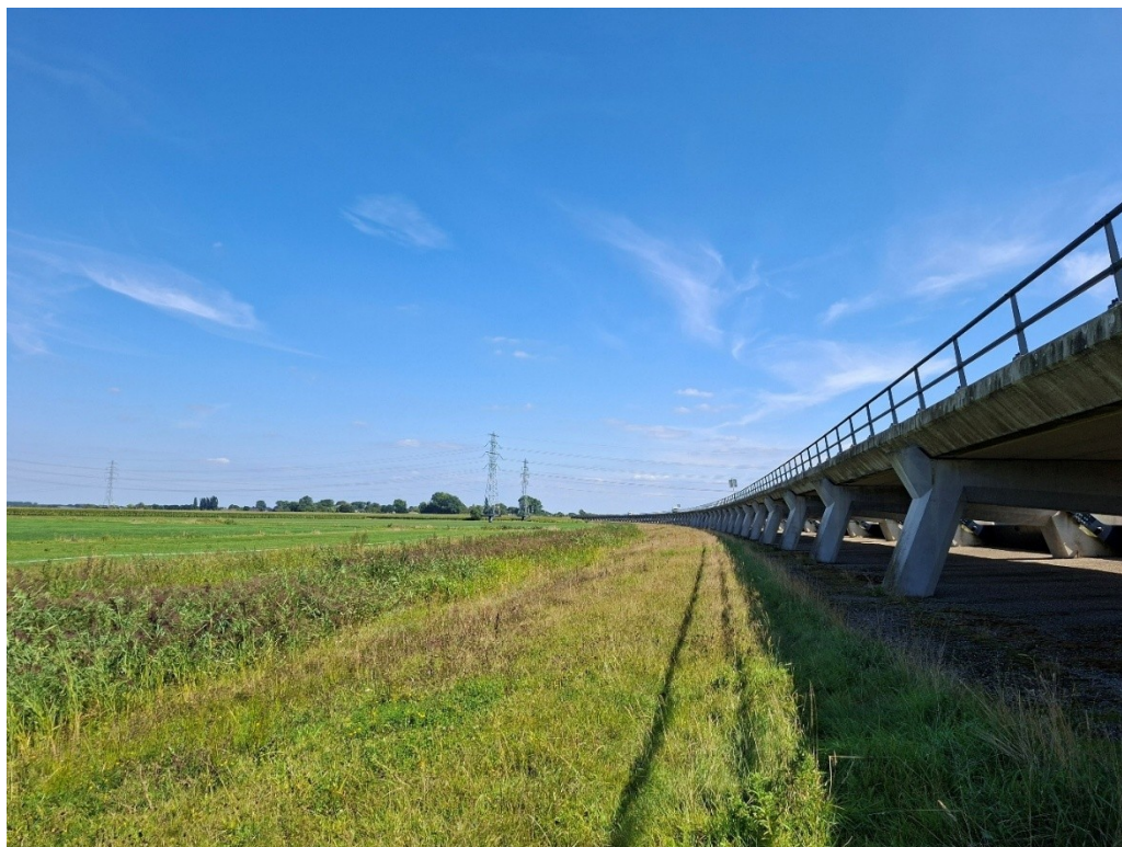
Foto aan de inlaatconstructie van de Hoogwatergeul
