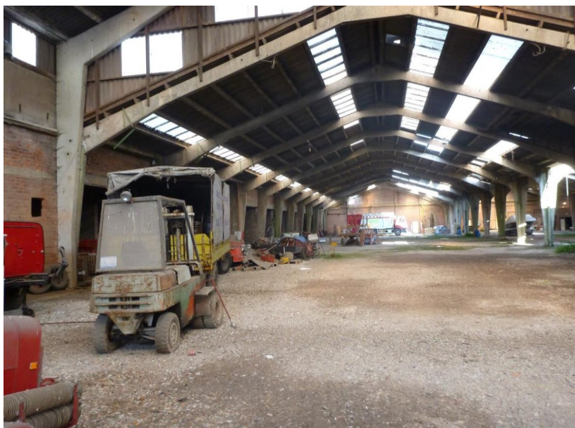
Foto 9 Zicht binnen in de voormalige steenfabriek (2)
