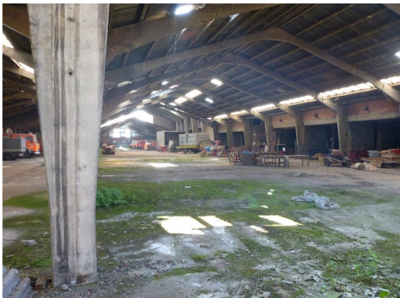
Foto 8 Zicht binnen in de voormalige steenfabriek (1)
