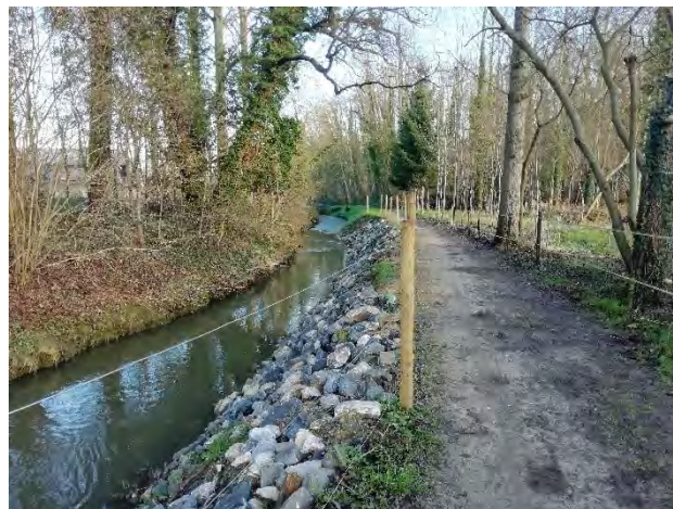
Foto: vastgelegde oever na eerdere afkalving
