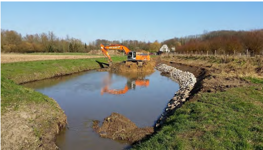
Foto: voorbeeld van een (kleine) sedimentvang onderaan een landschap
