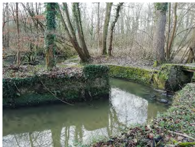
Foto: Bakstenen constructie ten zuiden van de Margijsbosweg
