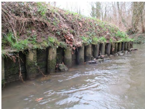
Foto: oeverbeschoeiing langs de oever van de IJse, inclusief steenbestortingen
