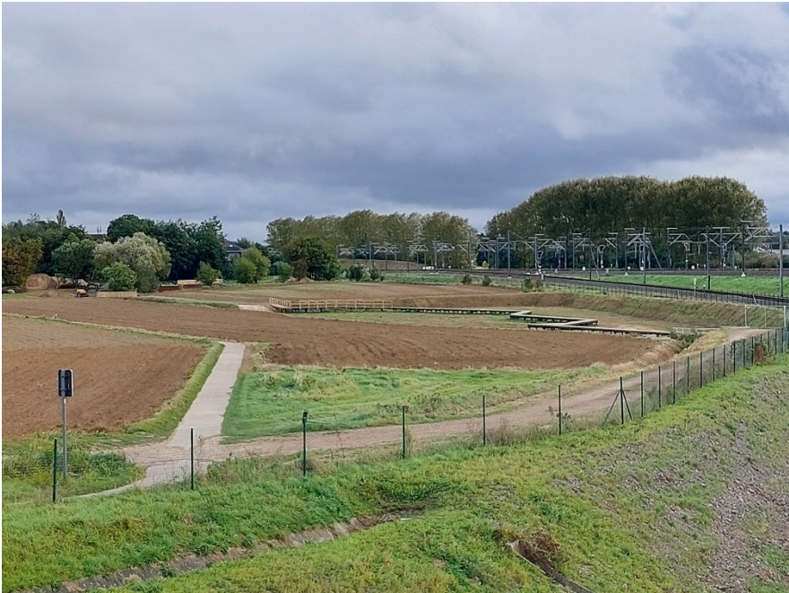
Figuur V-91: Huidige situatie Bufferzone Kleine Beek met reeds ingericht bufferbekken van Infrabel met vlonderpad, maar met een reële nood tot meer buffervolume en een sponslandschap voor stroomafwaartse bescherming tegen wateroverlast.
