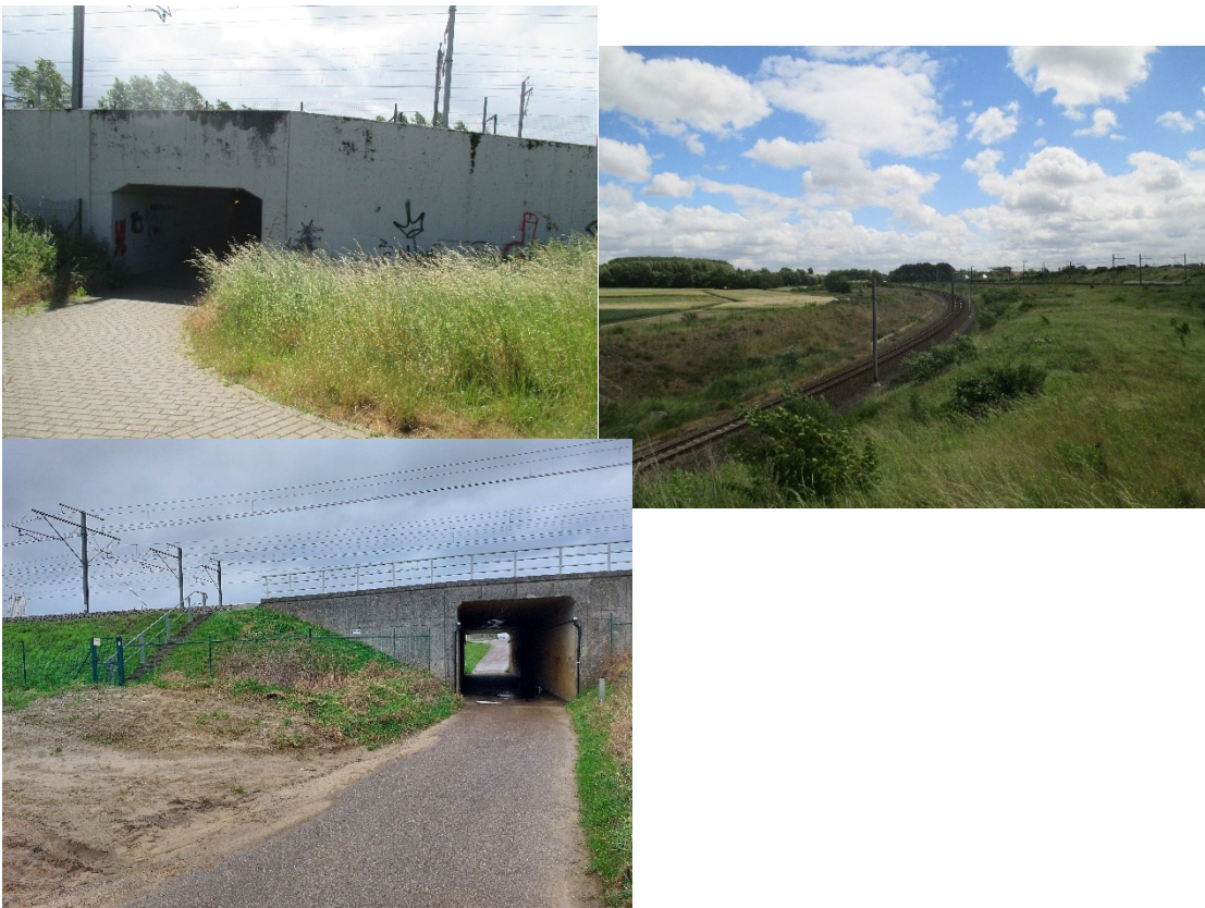
Figuur V-63: Huidige tunnels zijn weinig aantrekkelijk (vaak met modder en graffiti) en vormen de enige doorgang onder de spoorweg dat een landschappelijke en ecologische barrière is
