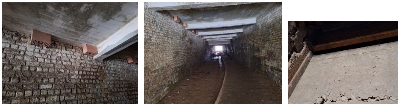
Figuur V-64: Snelbouwstenen en dwarsbalken zorgen voor schuilhokken en holtes waarin vleermuizen kunnen overwinteren.
