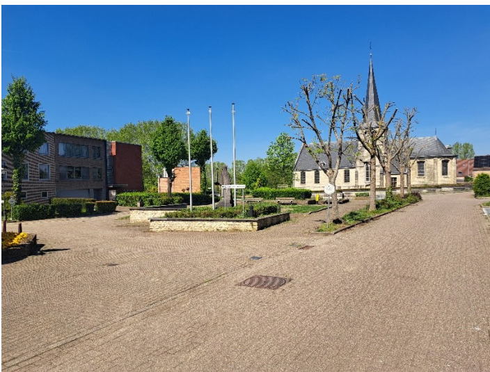
Figuur V-153: Het huidige kerkplein en aanliggende parking is een grotendeels versteend oppervlakte met weinig groen en waterbufferingsmogelijkheden
