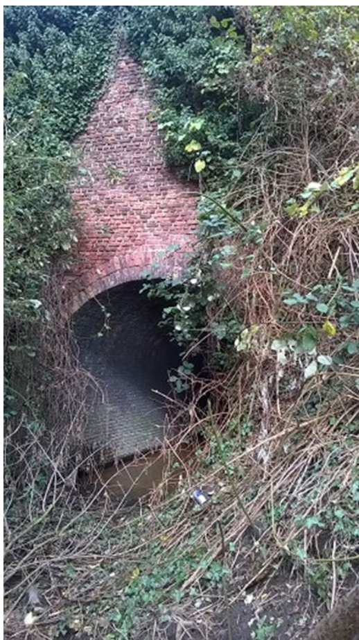
Foto: Tunnel ID 2
