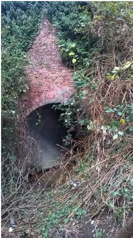
Foto: Tunnel ID 2
