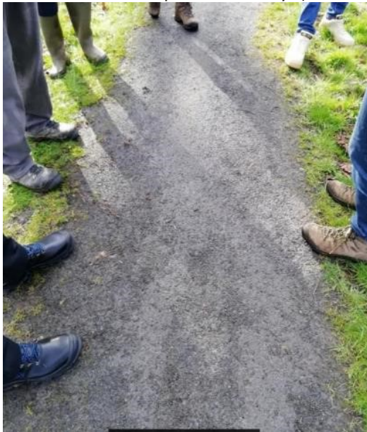
Foto 7: bestaande verharding rond St-Jansvijver- VLM-03/03/20
