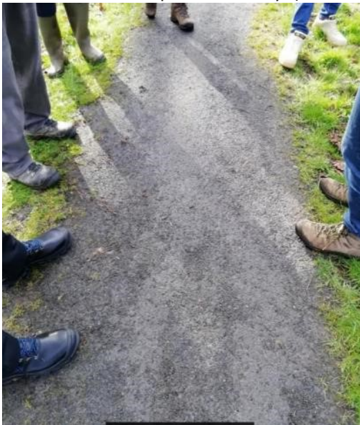
Foto 7: bestaande verharding rond St-Jansvijver- VLM-03/03/20
