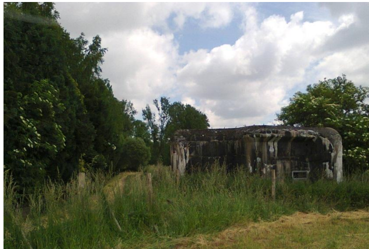
bunker t.h.v. Veeweide
