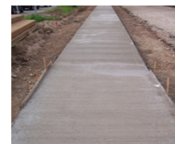
fietspad in uitgewassen cementbeton
