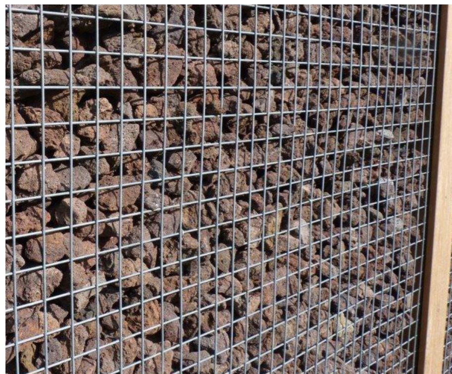
grondkering mbv schanskorven gevuld met RODE LAVASTEEN of met SPOORBALLAST
