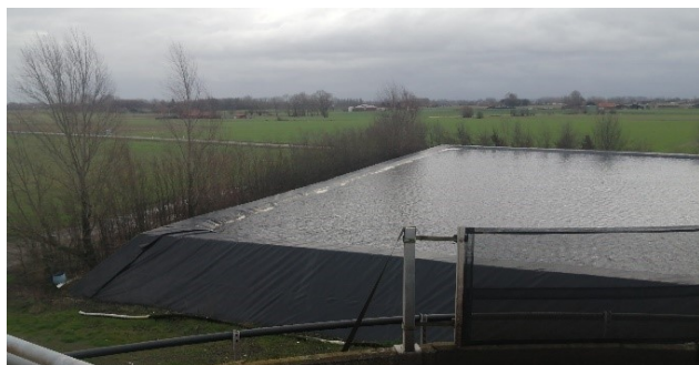
Vaststellingen bij omgevingscontroles op mestverwerkingsinstallaties: links: te hoog gevuld bekken, met ernstig risico op overlopen rechts: overlopen van dunne fractie uit een bekken omdat deze te hoog gevuld was
