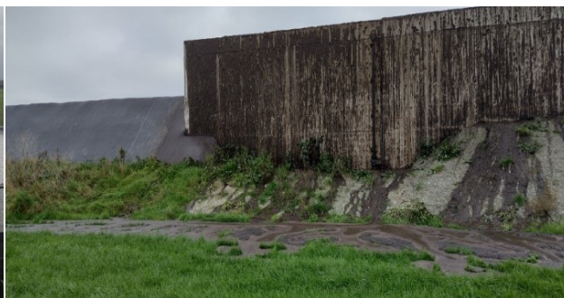
Vaststellingen bij omgevingscontroles op mestverwerkingsinstallaties: links: te hoog gevuld bekken, met ernstig risico op overlopen rechts: overlopen van dunne fractie uit een bekken omdat deze te hoog gevuld was
