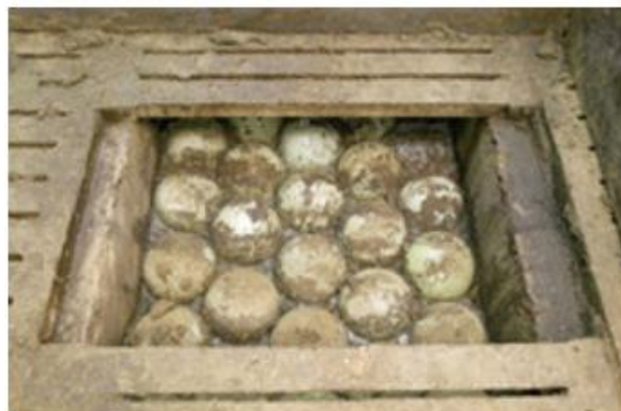
Figuur 39 Voorbeeld van een mestkelder afgedekt met balansballen (bron foto: www.balansbal.nl )
