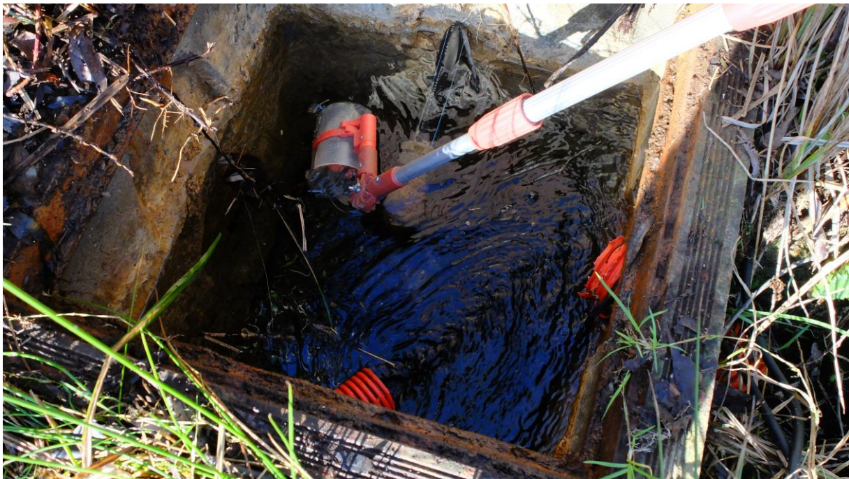
Fig 2.5 Collectorput waarin de drainbuis uit de heuvelflank instroomt
