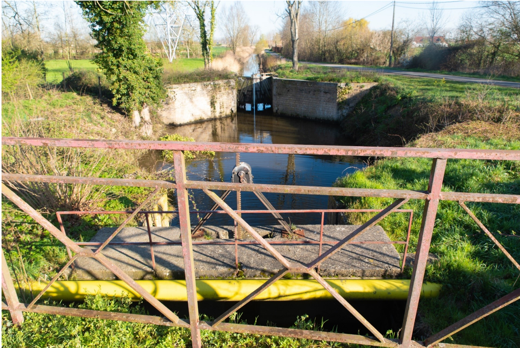
Figuur 2: Zicht op Speisluis, Fotoarchief VLM (2023).
