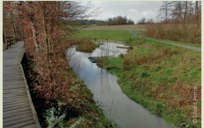
Rechts van het vlonderpad werd een ruim natuurlijk bufferbekken aangelegd. Links van het pad werd de betonnen blusvijver onthard en omgevormd tot een ecologische poel met natuurleerelementen.
